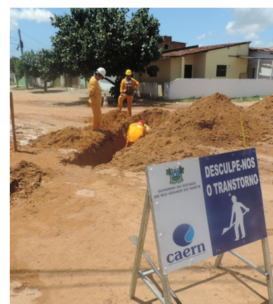
Caern realiza maior obra de esgotamento do RN
